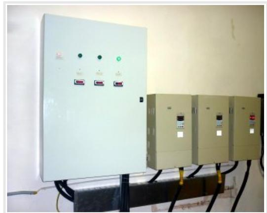
Была проведена установка ПЧ мощностью 55 кВт на трех магистральных насосах (один — основной, другой резервный, третий — на регламентных работах). На каждый электродвигатель «свой» преобразователь и датчик давления. До установки ПЧ давление регулировалось задвижкой на входе магистрали.
